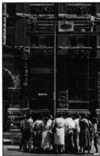
Une démonstration de nettoyage chimique de la maçonnerie, dans le cadre du cours d'été en rénovation et restauration. (photo: Héritage Montréal)
