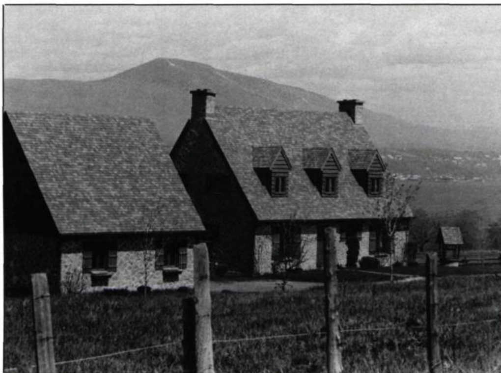
Une copie de maison traditionnelle, à l'île d'Orléans. Certains traits indiquent qu'il s'agit d'une imitation: la pente trop prononcée du toit, ses proportions exagérées, son recouvrement en bardeaux d'asphalte, la pierre des murs posées à angle et au fond, une imitation de puits en miniature. (photo: F. Lachapelle)
