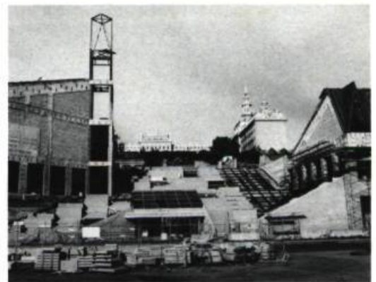
Vue du chantier du Musée de la civilisation à Québec, en août 1986. (photo: B. Ostigey)
