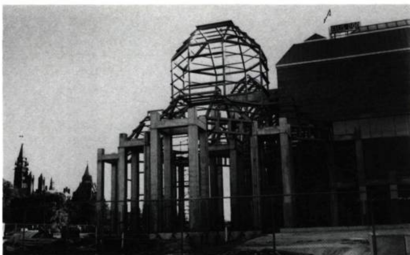
Vue du chantier du Musée des beaux-arts du Canada à Ottawa en août 1986. (photo: M. Chevalier)
