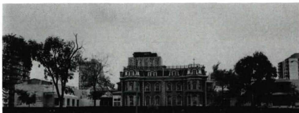
Vue du chantier du CCA à Montréal, en août 1986. (photo: R. Hébert)
