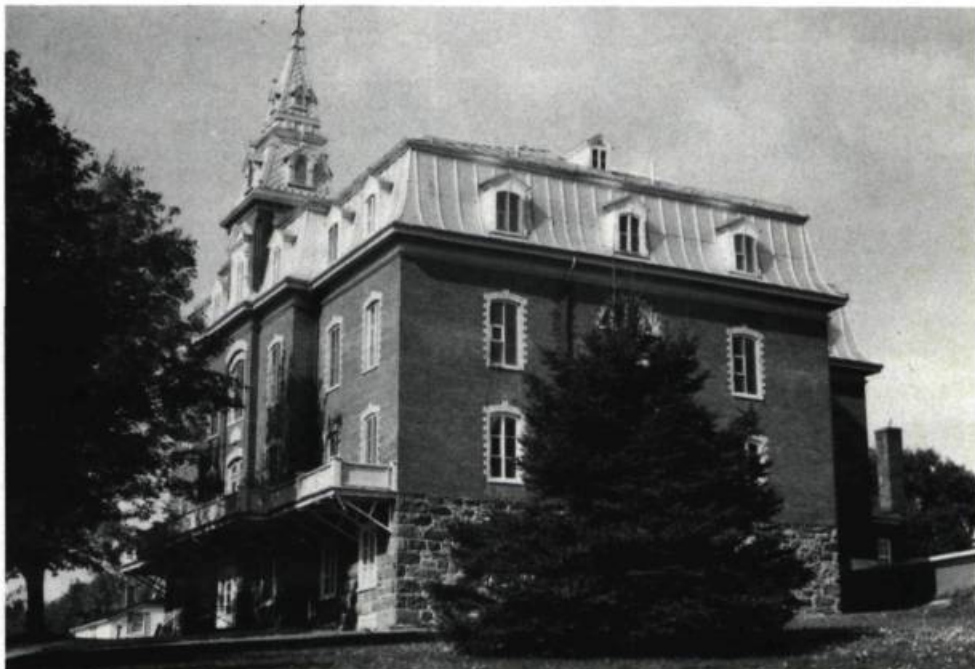
L'ancien couvent de Saint-Joseph, recyclé par la Ville, abrite entre autres le Musée Marius-Barbeau et les locaux de la Société du patrimoine des Beaucerons. (photo: MAC).
