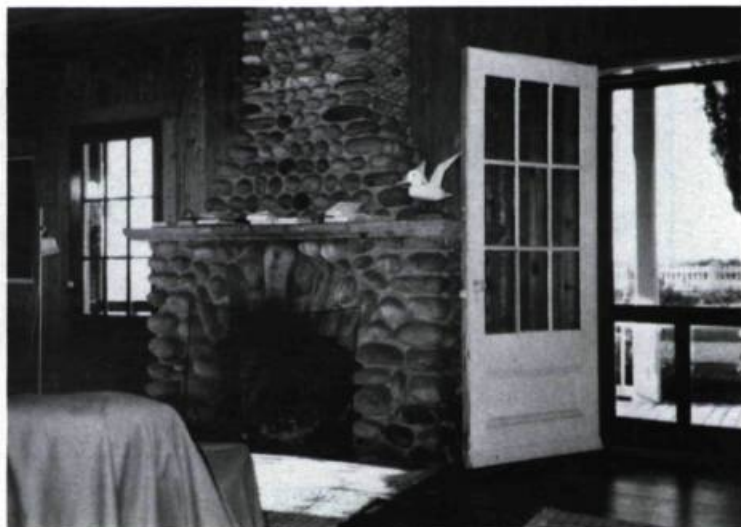
L'immense foyer de la pièce de séjour construit avec les galets de la plage voisine. (photo: D. Lemieux)
