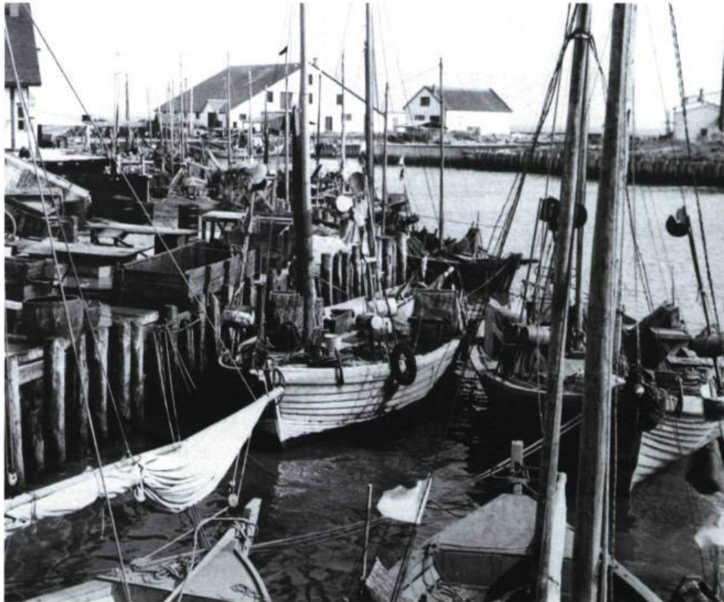
Derrière les bateaux amarrés à L'Anse-à-Beaufils se profilent les bâtiments destinés à la préparation et à l'entreposage du poisson. (photo: Inventaire des biens culturels)
