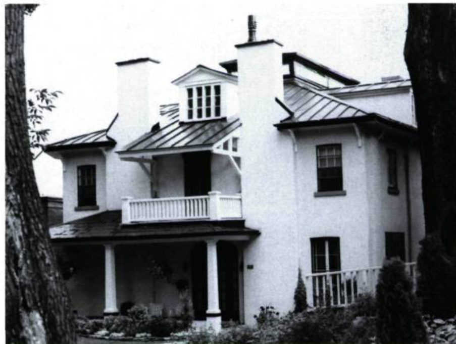
La ferme Outre-Mont, 221-223, McDougall (1833-1838). Photo: Continuité.
