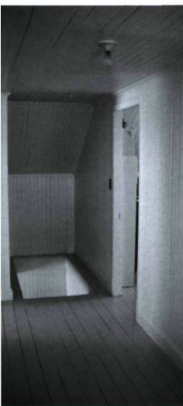
Intérieur entièrement recouvert de planches emboutées rainurées en «V» typique du début du siècle. Photo: François Varin.
