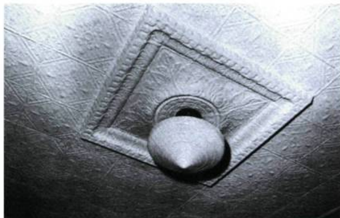
Plafond décoré d'un revêtement de feuilles de tôle pressée avec une tôle particulière pour inscrire le luminaire au centre de la pièce. Photo: I.B.H.C., Parcs Canada.
