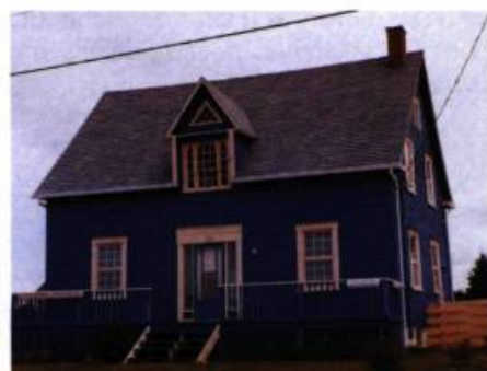
Les galeries sont de différents styles : avec balustrade ou mur à mi-hauteur en guise de balustrade.
