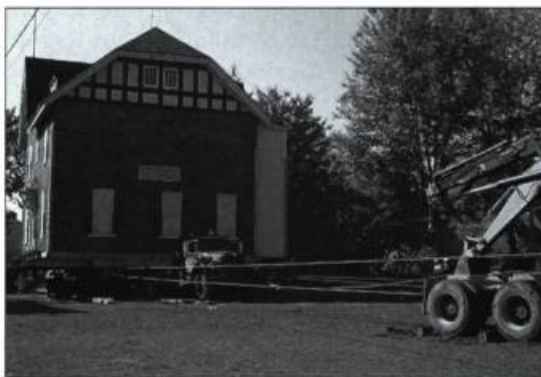
Photos : Service d'urbanisme, Ville de Québec
