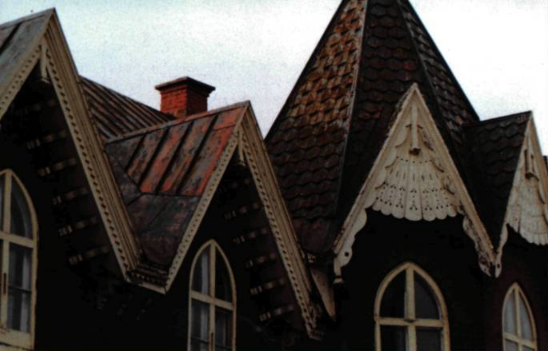
Une toiture aux nombreux « accidents » de volume : un avant-corps surmonté d'un toit conique hexagonal recouvert d'une tôle à motif imitant la tuile et percé de petits frontons en pignon revêtus d'une tôle à baguettes et un toit à deux versants recouvert d'une tôle à baguettes.
