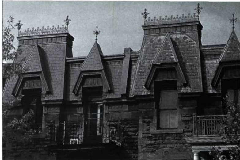
Architecture résidentielle typique de Montréal qui montre l'usage de l'ardoise au tournant du siècle. À remarquer : les épis et crêtes décoratives de fonte.
