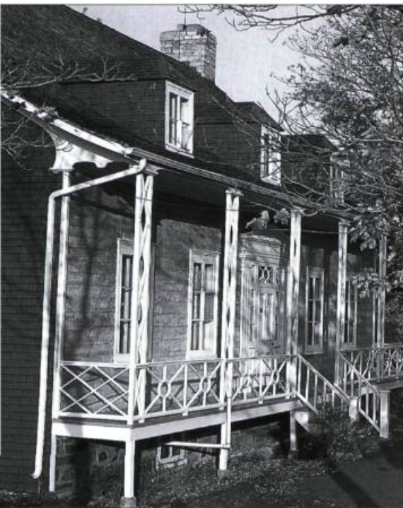
Presbytère de Saint-François, 1867. Dans le modèle vernaculaire québécois, l'expression classique apparaît entre autres dans la symétrie des éléments, dans le profil « à la chinoise » des pignons et dans les éléments décoratifs du portail et des intérieurs. Photo : Brigitte Ostiguy
