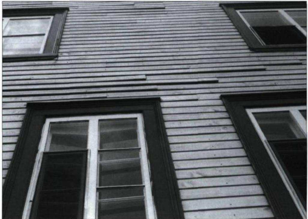
Illustration C Planches cornières moulurées. Le revêtement vient buter sur les planches cornières. Source : Guide technique n° 4, Revêtements traditionnels , publié par Héritage Montréal
