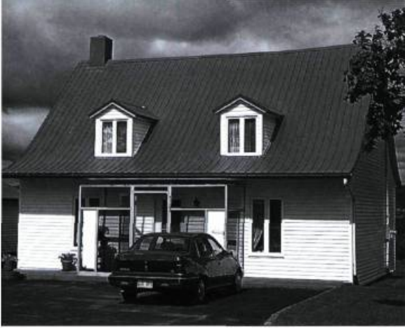
Cette maison «rénovée» n'est plus qu'une caricature d'elle-même. L'aluminium a remplacé le clin de bois. Les fenêtres neuves ne portent plus la trace des carreaux d'autrefois, le portique masque la devanture. Photo : Brigitte Ostiguy
