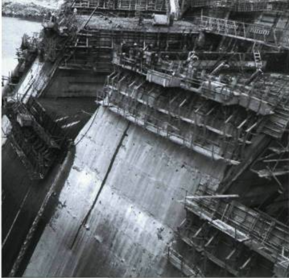
En 1965, construction du barrage Manic 5, d'une hauteur de 214 mètres.
