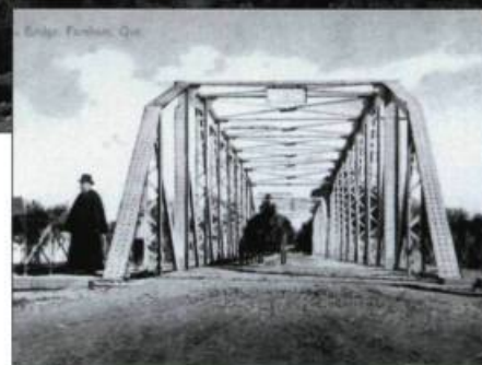
Le pont de Farnham, un des ponts de l'ingénieur Macquet, utilisait deux travées Schwedler. Érigé entre 1887 et 1892, il est aujourd'hui disparu.
