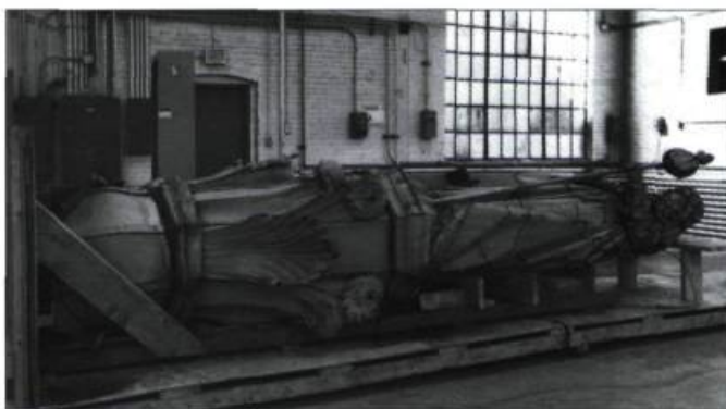
On voit ici la statue dans un entrepôt de l'UQAM avant restauration. On a dû l'amputer de la partie inférieure du pinacle qui lui servait de socle afin de la fixer plus solidement sur la façade de la transept sud.
