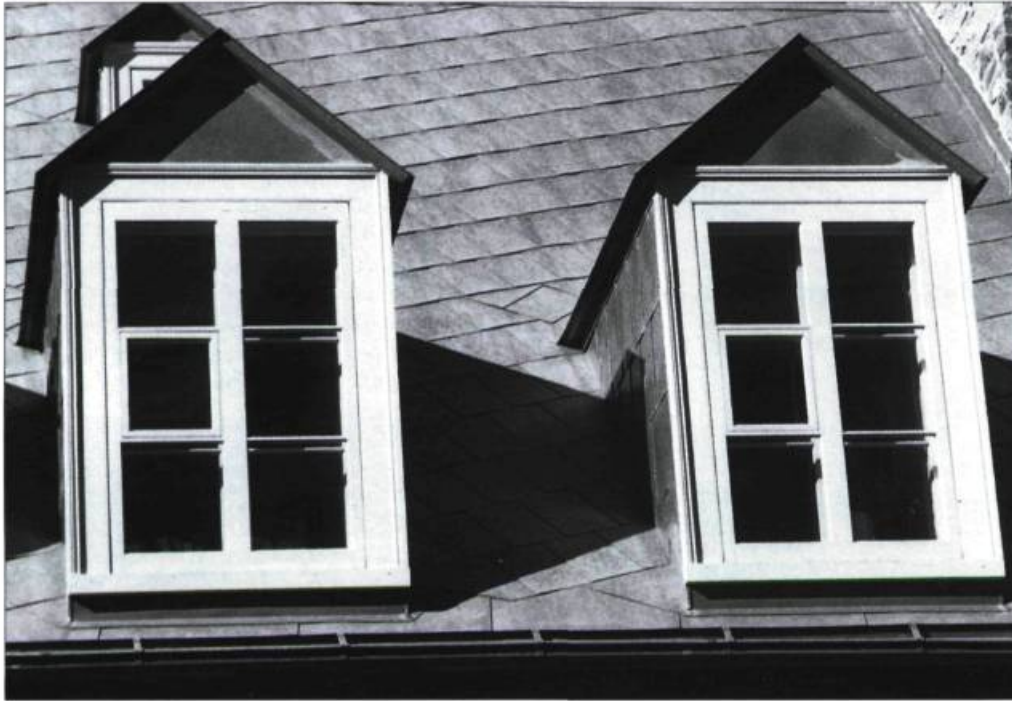
Lucarnes à fronton-pignon dont les jouées et la toiture sont revêtues de tôle à la canadienne.
