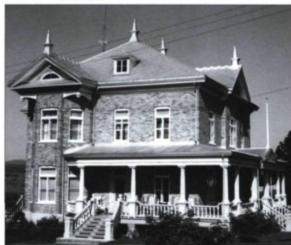
À proximité de l'église de Saint-Louis-du-Hal-Hal, le presbytère datant de 1908 fait partie d'un ensemble institutionnel bien conservé et d'une valeur patrimoniale certaine.
