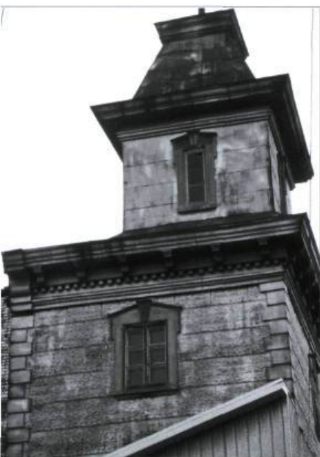
Tout ce bâtiment est recouvert de tôle. Seul le traitement diffère d'une partie à l'autre : effet de pierre bouchardée, de pierre de taille pour le chaînage d'angle et corniche de tôle.
