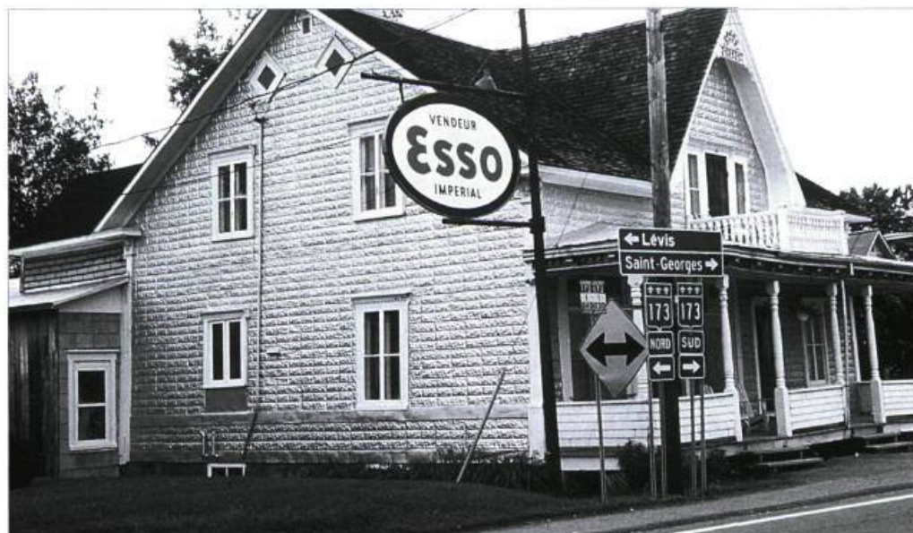
Résistante, la tôle embossée nécessite l'entretien habituel de la tôle : ponçage, apprêt antirouille et peinture à métal.
