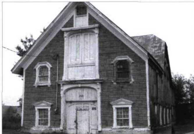
Les matériaux développés pour diminuer les coûts de construction donnent un aspect recherché aux édifices. Sur ce bâtiment secondaire, le revêtement d'asphalte est à motifs de pierres.
