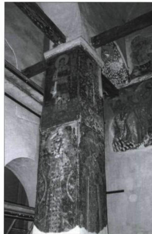
Fresques religieuses ornant les murs de l'église de Bogorodica Ljeviska. En mars 2004, ces peintures ont été criblées de balles et sont maintenant fortement endommagées.
