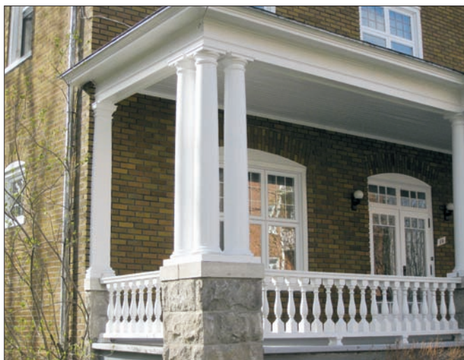
La base de la colonne repose parfois sur un pilastre de pierre.
