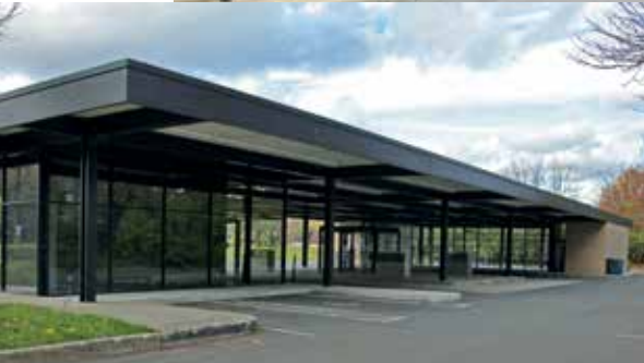
La station-service avant sa conversion
