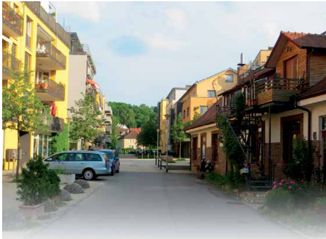
Les dépendances du quartier Loretto (à droite) ont été recyclées et intégrées à un cadre bâti résolument contemporain.
