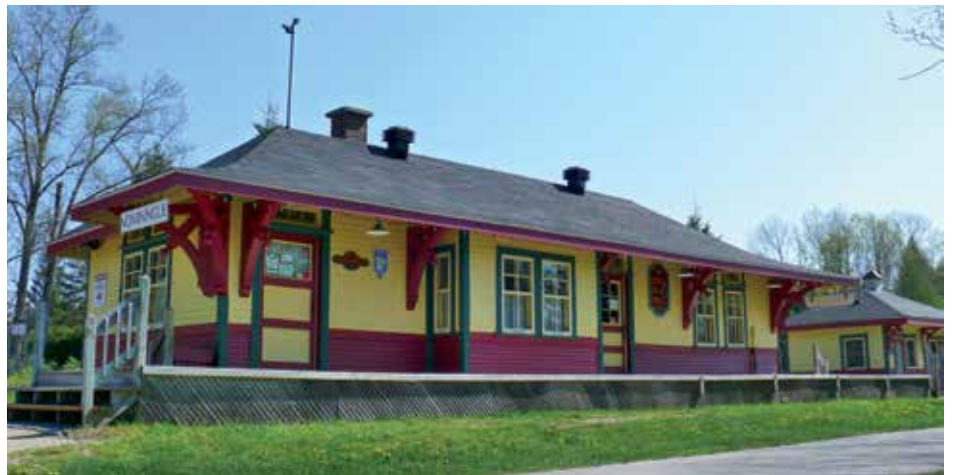
L'une des dernières gares du Canadien Pacifique à subsister dans les Laurentides est celle de Nominique, d'une valeur exceptionnelle selon l'inventaire du patrimoine de la MRC.
