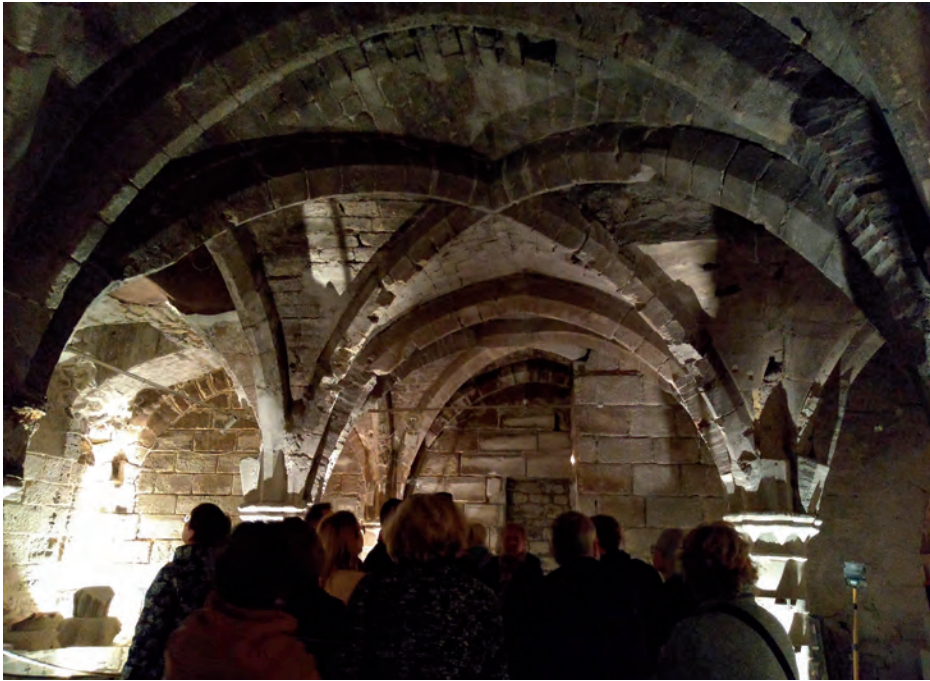
L'organisme Paris Historique travaille actuellement à la restauration du cellier gothique du XIII e siècle de la maison d'Ourscamp.
