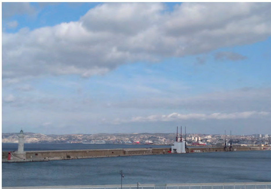
Les membres du Comité du Vieux-Marseille se réjouissent de la restauration des cinq grues emblématiques de la digue du Large, surnommées « les élégantes ».
