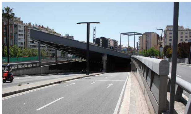
Autoroute Ronda del General Mitre sous la place de Lesseps Photo : Jacques Plante
