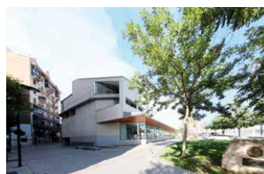
Angle sud-ouest Photo : Jacques Charbonneau
