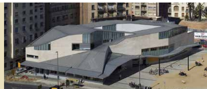
Toiture ondulante en zinc Photo : Julio Cunill Zapata
