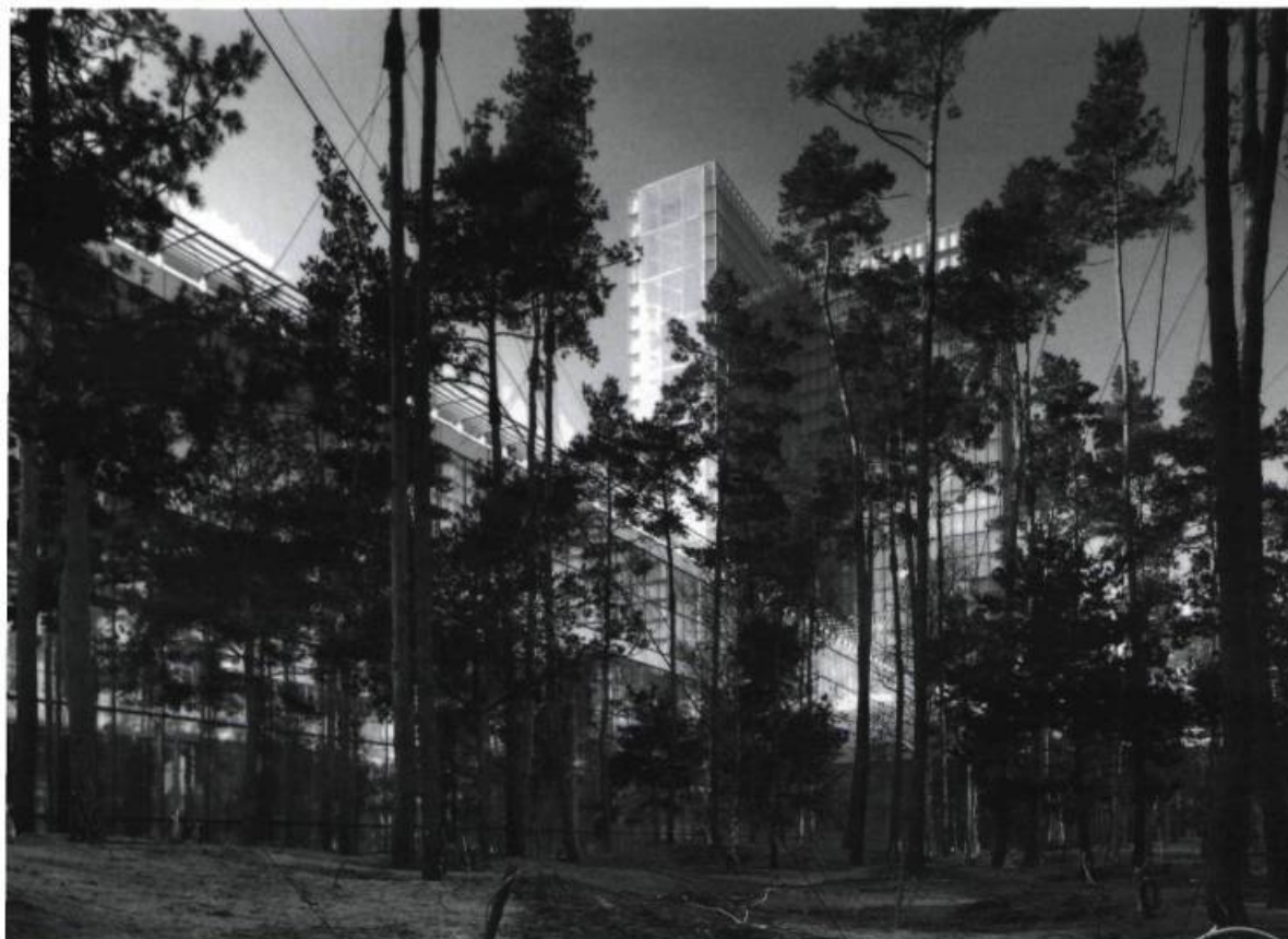
Le chantier de la BNF à Tolbiac. Architecte : Dominique Perrault. Photo : Alain Goustard.
