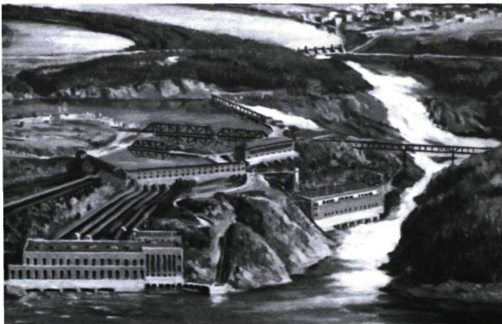
Le complexe hydroélectrique de Shawinigan. D'après une peinture de H. Leslie
