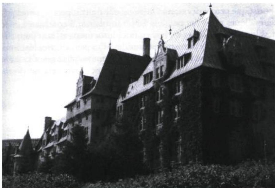
nistre, soit en octobre 1928, les travaux de fondation sont en train. La construction est délicate, du fait de l'isolement du site et des délais très courts. Pour éviter les possibilités d'un autre incendie, l'édifice est construit en béton armé avec un toit en charpentes métalliques recouvertes de cuivre.
