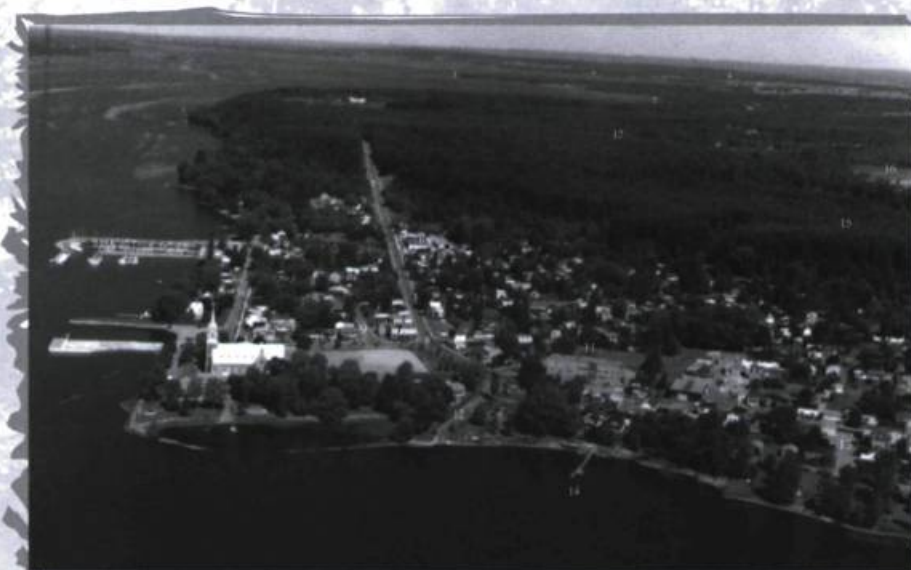
Vue aérienne sud-est de la Pinède. (Source : Fonds Philippe Chéné)
