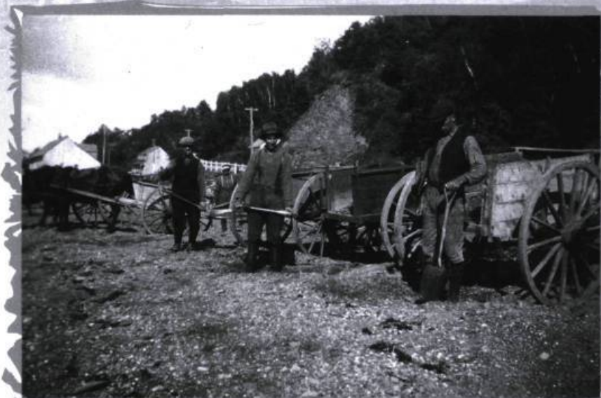
Construction de la route du Fleuve, face au Rocher Malin. Sont présents sur la photo MM. Alphée April, Henri Lebel et Oménil Boucher. (Source : Collection Patrimoine et Culture du Portage)
