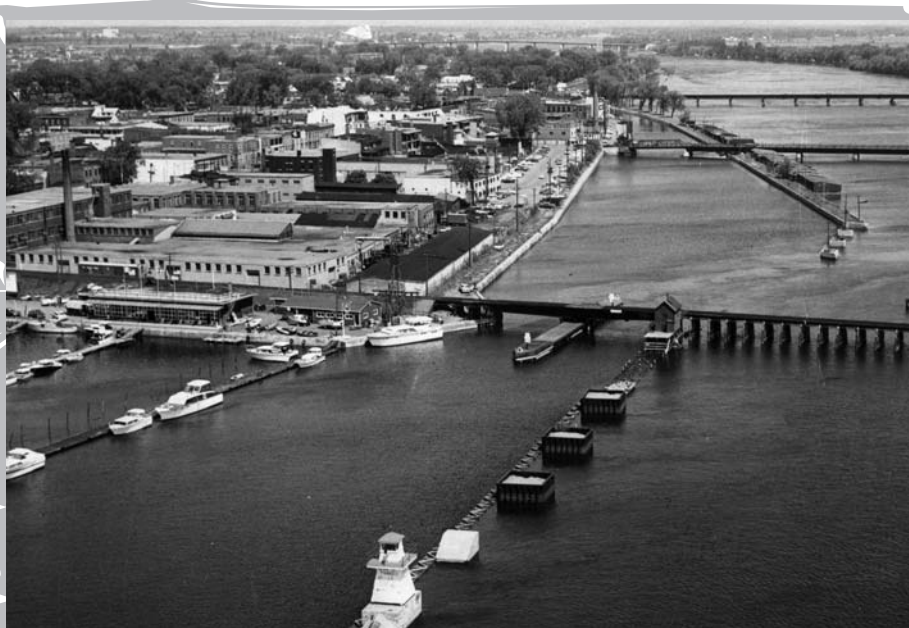
L'entrée sud du canal de Chambly, vers 1960. On peut y percevoir les interactions entre l'industrie et l'ancien port. (Source : Collection Parcs Canada)
