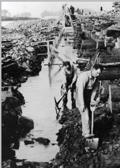
Voici les deux outils qui ont permis de creuser des centaines de kilomètres de canaux. Travailleurs au canal de Sainte-Anne-de-Bellevue, détails, 1920. (Source : Parcs Canada/160/00/1c-35)
