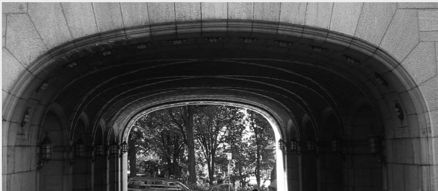
Intérieur de l'une des deux portes cochères du château Frontenac. (Photo : Émile Audy)
