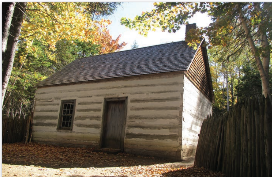
Maison Martin sur le site du Village Historique Acadien, de type pièce-sur-pièce, datant de 1770. (Source : Village Historique Acadien)
