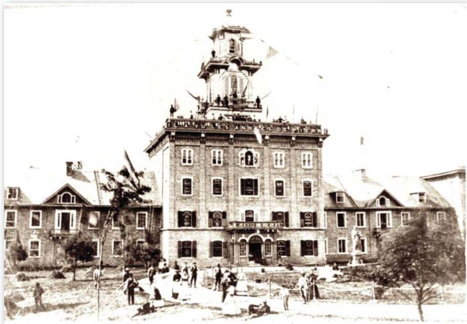
Photo de la façade de l'Asile de Beauport vers 1871. Elle fait partie de la collection du Musée Lucienne-Maheux
