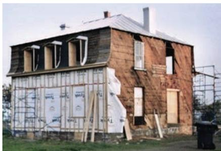
Lors du curetage de la maison, nous avons dû, à notre grande surprise, enlever quatre couches de revêtement : bardeaux d'amiante, papier brique rouge, vieux déclin de bois, planches en oblique et arrivées aux pièces sur pièces, en réparer quelques-unes... sous les fenêtres du côté est.
