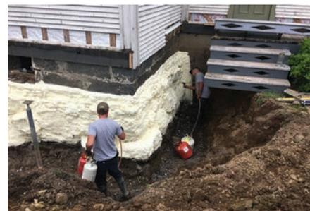
Les fondations ? Quant à faire... elles furent nettoyées, isolées à l'uréthane giclé et couvertes d'une membrane Platon. Nous avons mis un drain français pour en assurer l'étanchéité et nous avons amélioré le sous-sol par l'ajout d'un plancher de béton chauffant. Oh le confort !!!
