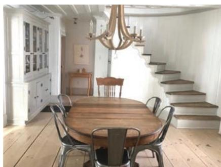
Les planchers étaient usés à la corde ! On les refit avec des planches de pin, teintées et vernies. Malheureusement, quelques parties de bois moins sec se mirent à écailler !!! On décida de tout sabler et de faire une finition à l'huile, de couleur claire et plus facile d'entretien !
