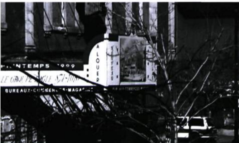
Façade du cinéma Séville en ruine.
