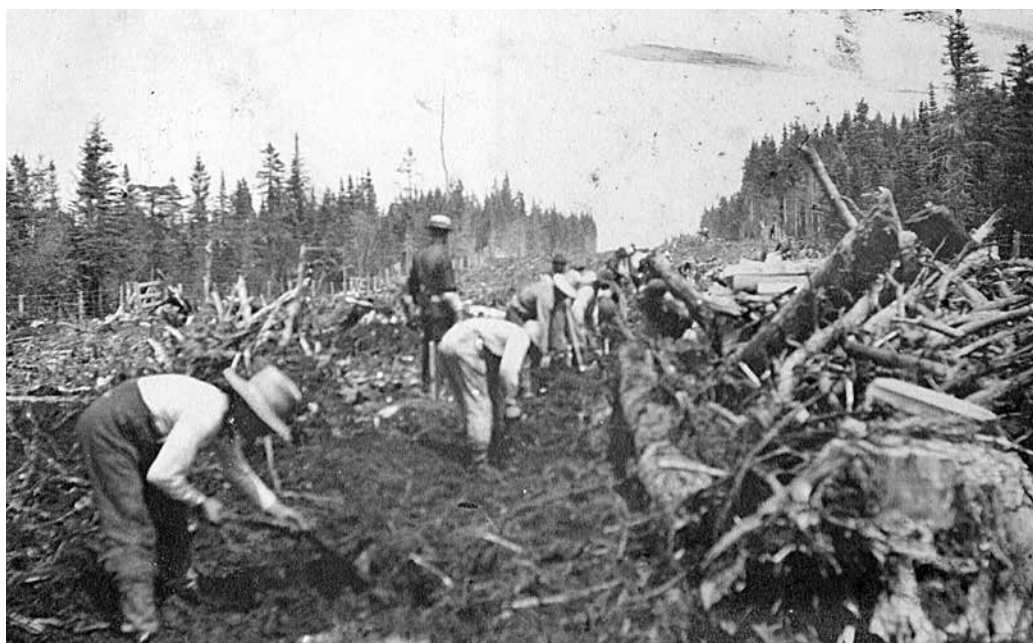
Des ouvriers abattent les arbres, arrachent les souches et creusent le terrain à la pelle et à la pioche. Il s'agit parfois de pêcheurs ayant choisit de « sauter » une saison de pêche pour travailler à la construction du chemin de fer. Juillet 1905.
