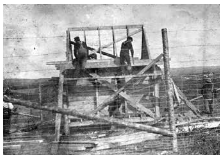
Construction d'une poudrière, utilisée pour conserver les explosifs, souvent essentiels pour « libérer » le passage ! Septembre 1905.
