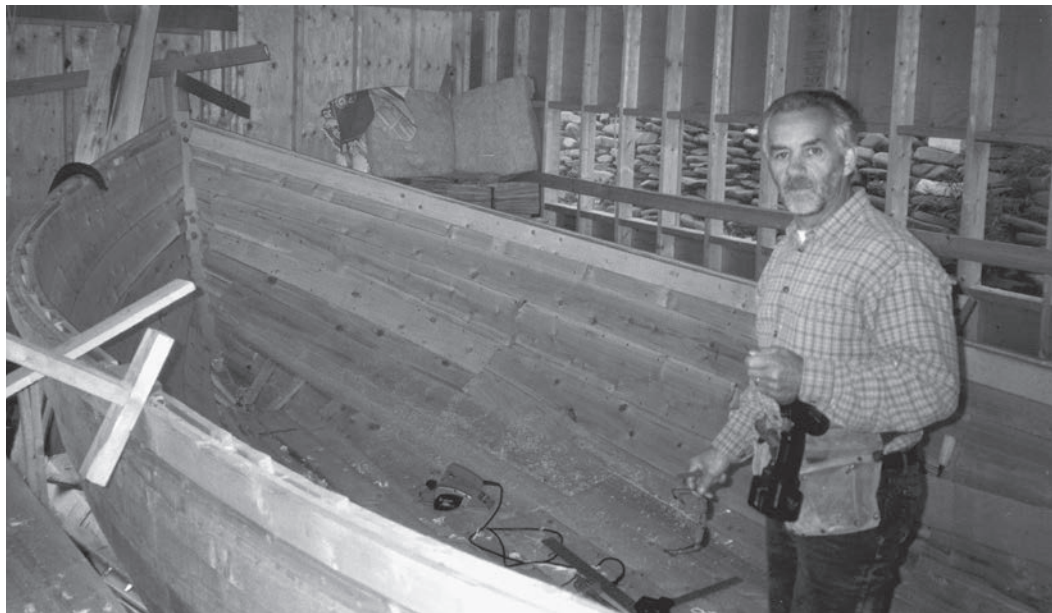
En 2004, Paul-Émile Cloutier est fier de compléter une des dernières étapes de la construction de sa barge. Il termine la pose du vaigrage – autrement dit, un « double fond » – pour protéger les membrures et les bordés. On voit clairement les bandeaux et les serres entourer les « hauts » de la coque et lui donner de la force. Cette barge sera mise en valeur dans la halte routière de Saint-Maurice. Photo : collection Paul-Émile Cloutier.
