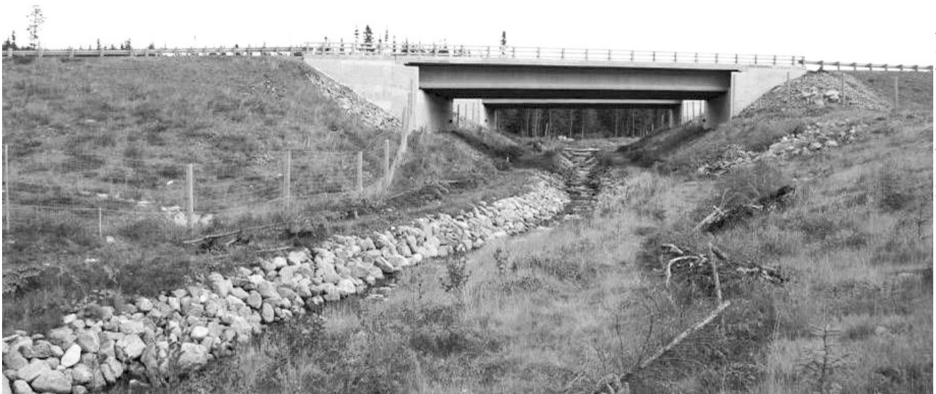
Figure 5. Passage faunique sous la route 175 dans la réserve faunique des Laurentides, aménagé pour l'orignal. Les clôtures sont des équipements essentiels pour assurer l'efficacité des passages fauniques.
