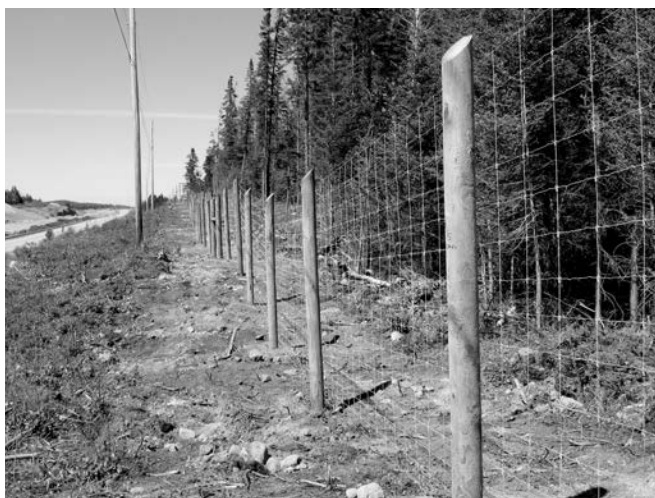
Figure 1. La clôture métallique de 2,4 m constitue une mesure d'atténuation efficace pour contrer les accidents routiers. Idéalement, l'aménagement doit être réalisé dans les secteurs les plus propices au passage des orignaux.
