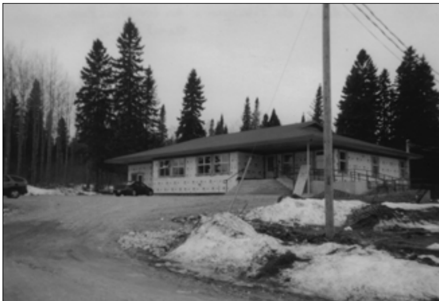
Garderie de Pikogan, en construction, avril 2002 (Photo Marie-Pierre Bousquet)
