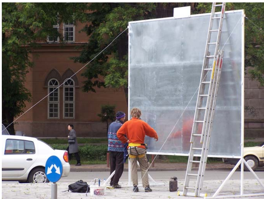
Figure 4 : Panneau d'affichage provisoire en cours d'installation près du château (Timisoara) (Photo de l'auteur, mai 2004)
