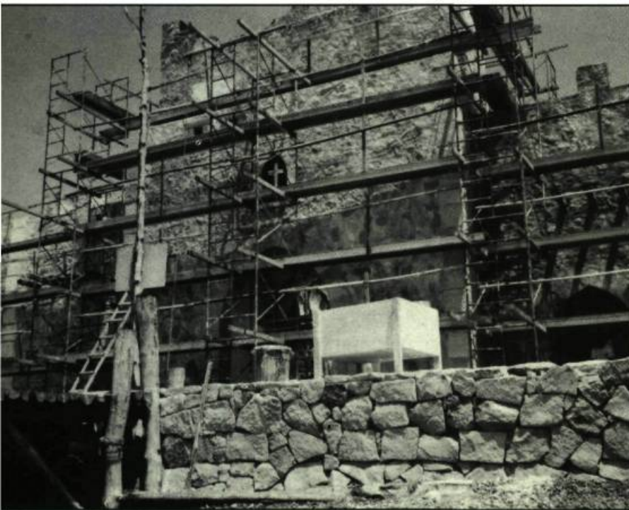
Construction d'une façade d'un château espagnol sur la plage d'Herradura
