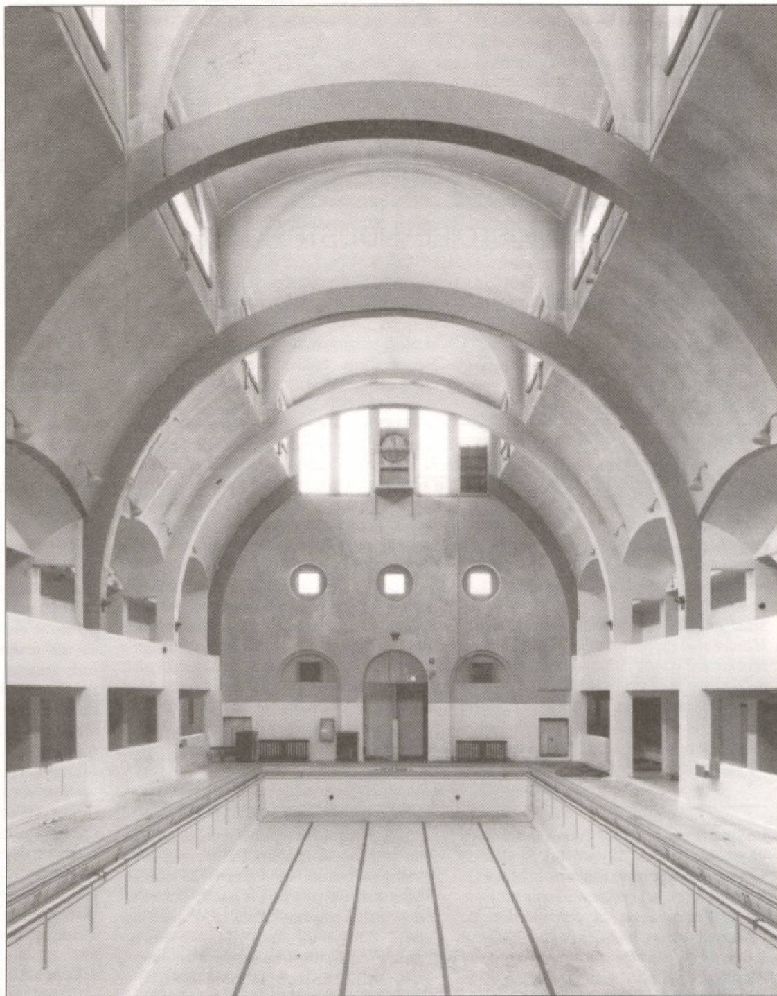
C'est le 30 septembre 1996 que seront officiellement inaugurées les nouvelles installations de l'ÉCOMUSÉE DU FIER MONDE au bain Généreux. Ici, l'équipement avant sa rénovation.
