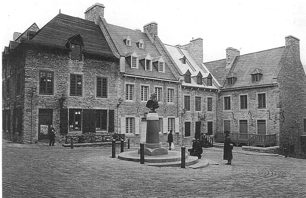
Figure 1b : Côté nord de la place, après les travaux. Source : Isabelle Faure
