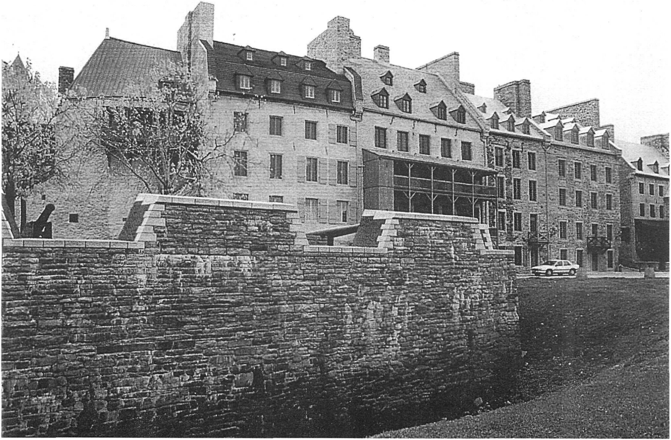
Figure 3b : La place de Paris, après les travaux. Source : Isabelle Faure
