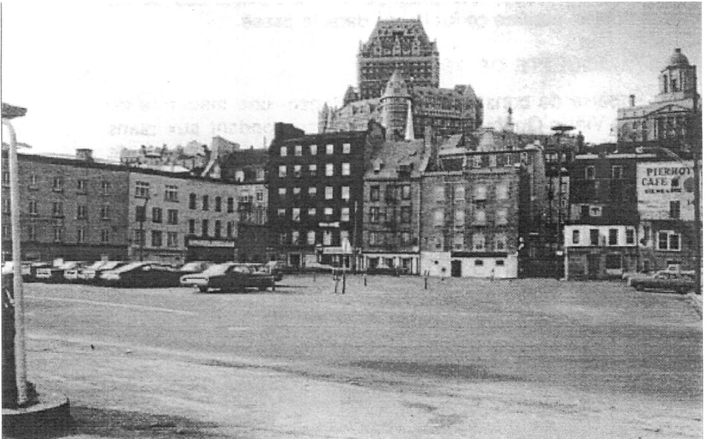
Figure 3a : La place du marché Finlay (place de Paris), avant les travaux. Source : Archives nationales du Québec
