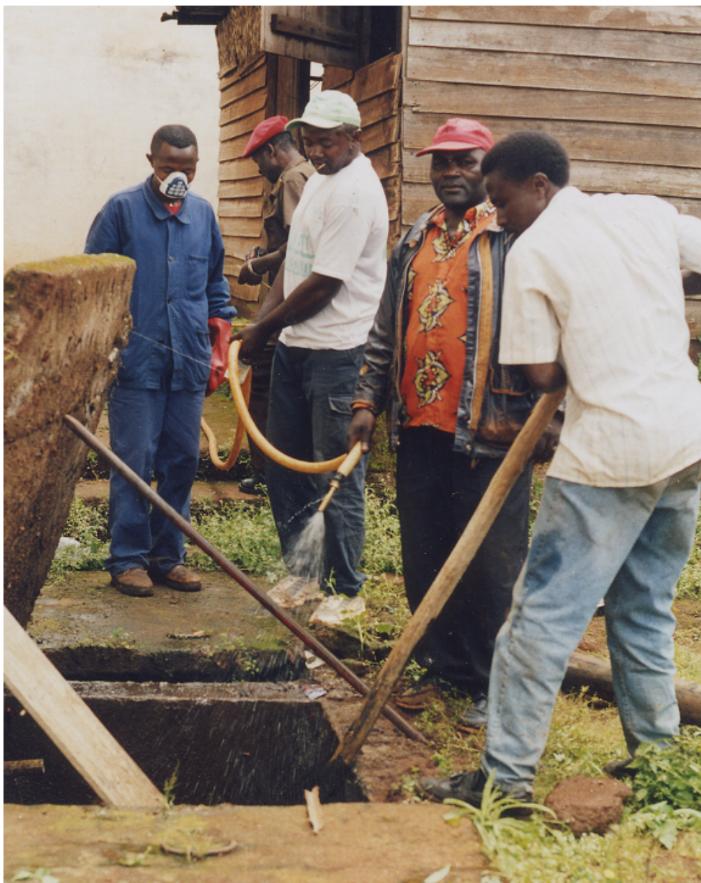
Figure 4. Séance de dilution des boues de vidange d'une fosse septique /Diluting the faecal sludge of a septic tank before emptying.
