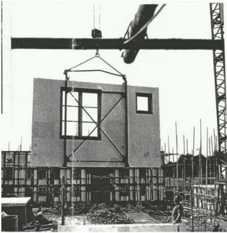
Figures 1. Pose des murs préfabriqués sur le chantier des 200 logements à Creil / Setting up the prefabricated concrete panels in the 200 houses construction site in Creil.
